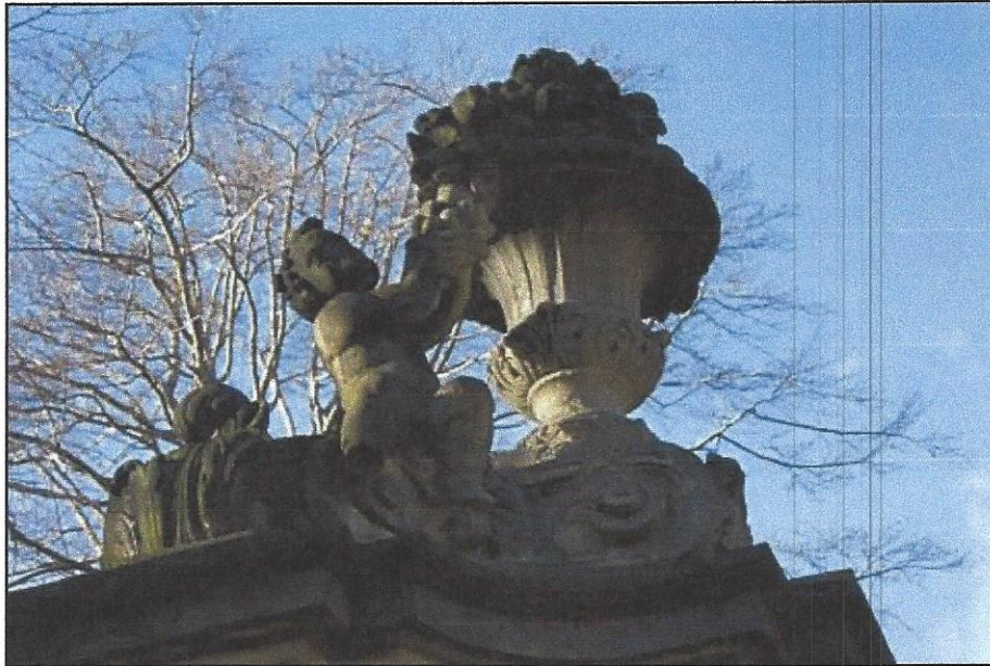
Fot.5 Stan zachowania rzeźby Putta z brakującą prawą stopą.
