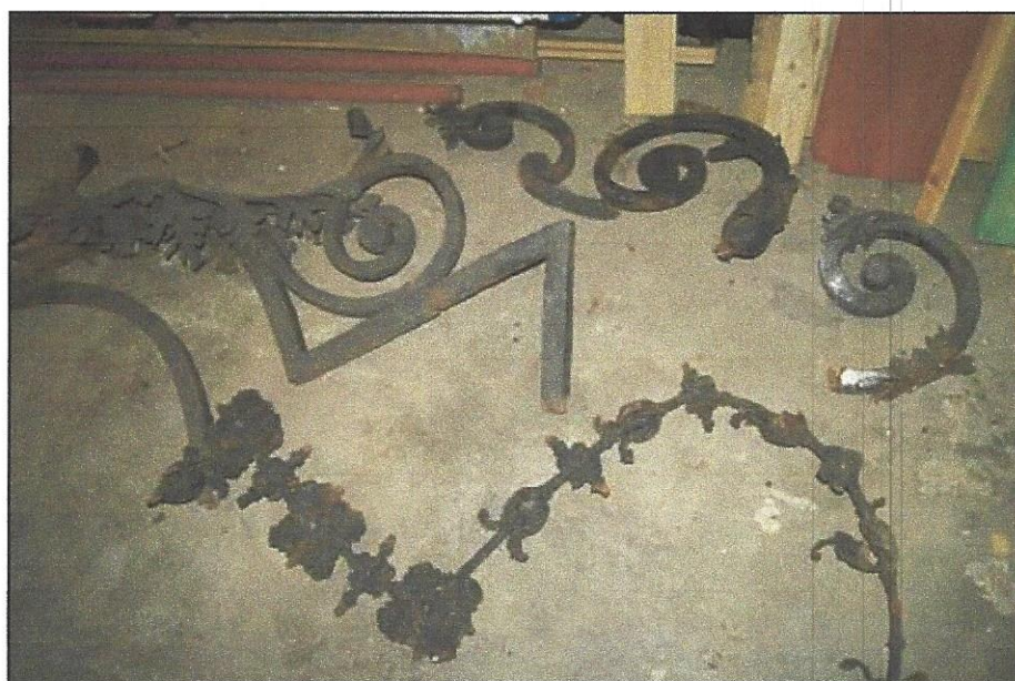
Fot.16. Elementy bramy. Widoczne zniszczenia.
