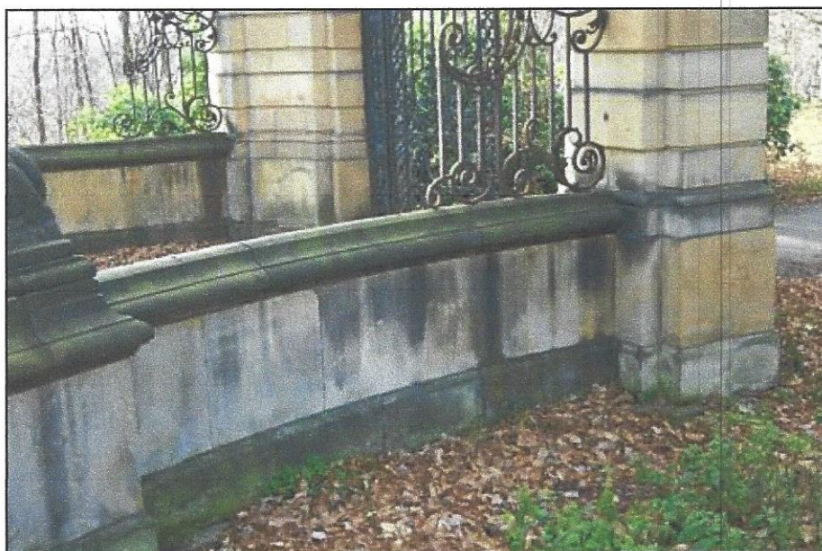
Fot.2. Stan przed konserwacją. Ujęcie murku poł.-wsch.
