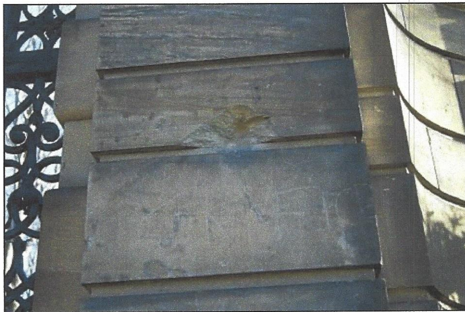
Fot.10 Stan przed konserwacją. Filar zachodni od strony południowej.
